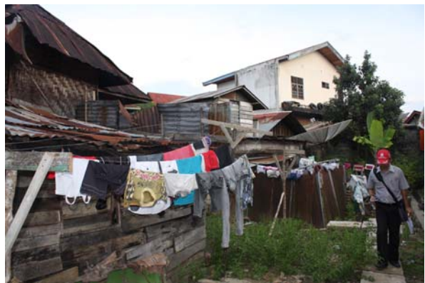
Gambar 5. Kondisi beberapa rumah yang tidak layak dengan jendela yang mini, material bangunan yang campur aduk.
