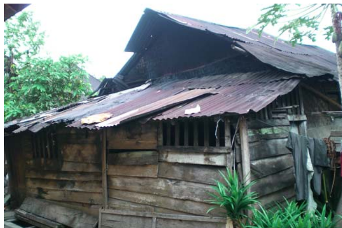
Gambar 6. Kondisi rumah yang memprihatinkan dengan dinding yang hampir roboh.
